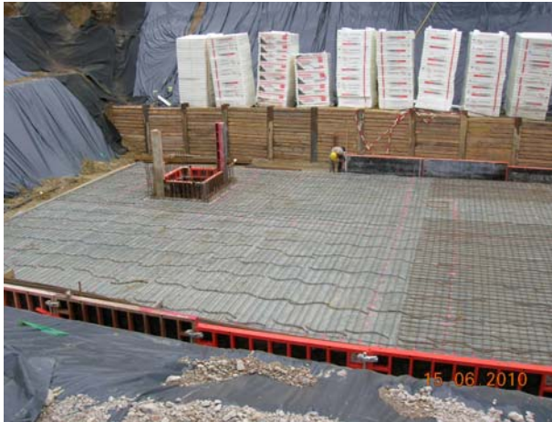
Vorbereitung zum Betonieren der Bodenplatte
