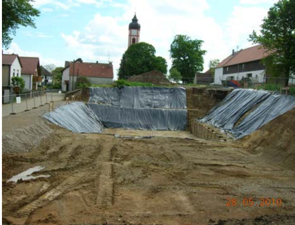
Blick zur Kirche im Vordergrund: nicht unterkellertes Bereich im Hintergrund: unterkellertes Bereich mit rechts zu sehendem Verbau (Baumschutzmaßnahme)
