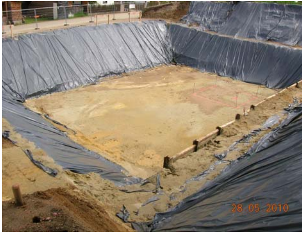
Teilunterkellertes Bereich mit rot markierter Aufzugsunterfahrt (rechter, oberer Bildrand)
